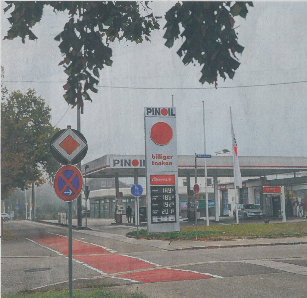
Die Pinoil-Tankstelle in der Bodenseestraße und die Gebäude eines ehemaligen Autohauses auf dem Grundstück sollen für eine neue Wohnbebauung abgerissen werden. Foto: Uwe Hirt
